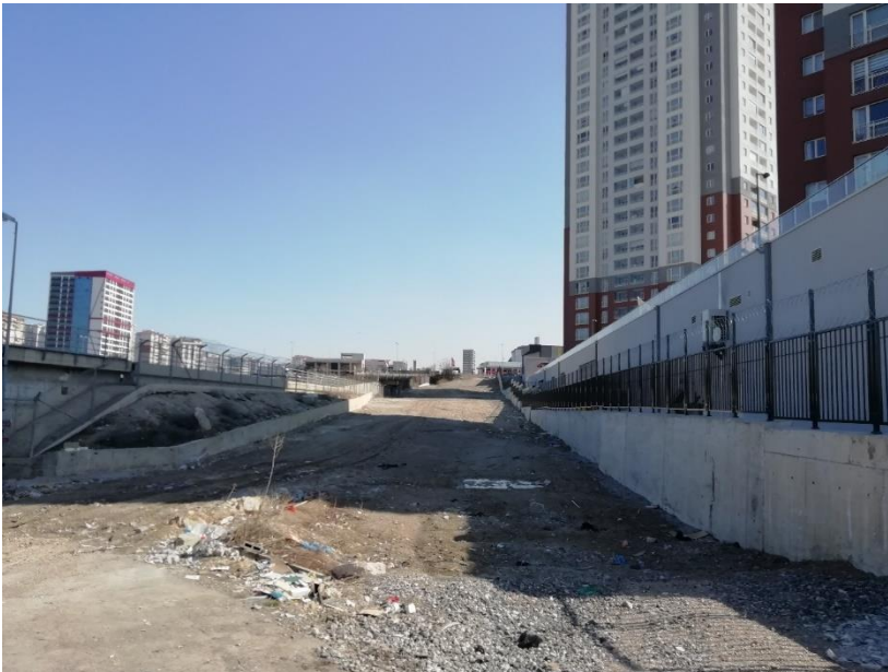
Şekil 2. YDA'da Sürmekte olan Altyapı Çalışmaları
