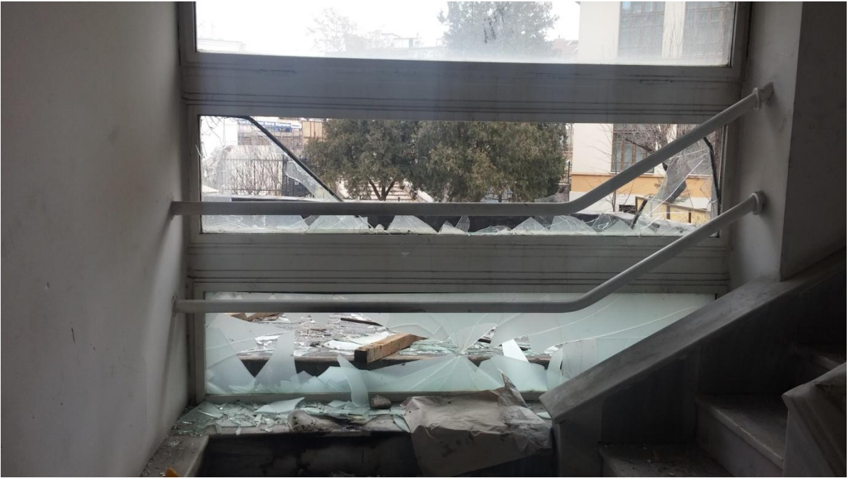
Şekil 29. İlker Bankası iç mekan şimdiki durum (Ocak 2017)
