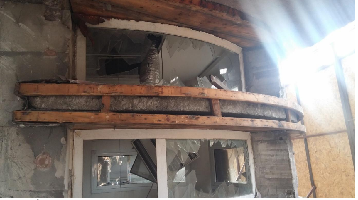
Şekil 30. İller Bankası cephe şimdiki durum (Ocak 2017)
