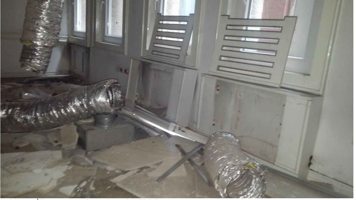
Şekil 28. İlker Bankası iç mekan şimdiki durum (Ocak 2017)
