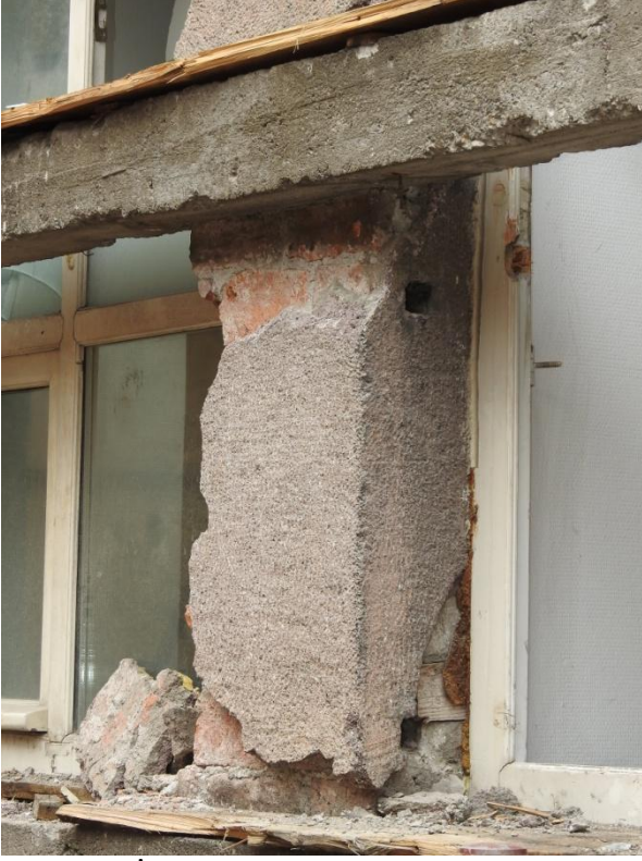
Şekil 32. İller Bankası cephe detayı şimdiki durum (Mart 2017)
