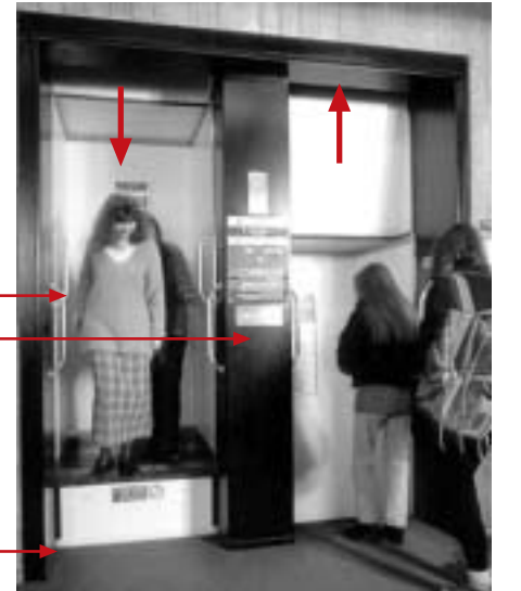
Resim 2: 30 cm/sn. hızla sürekli dönen paternoster
