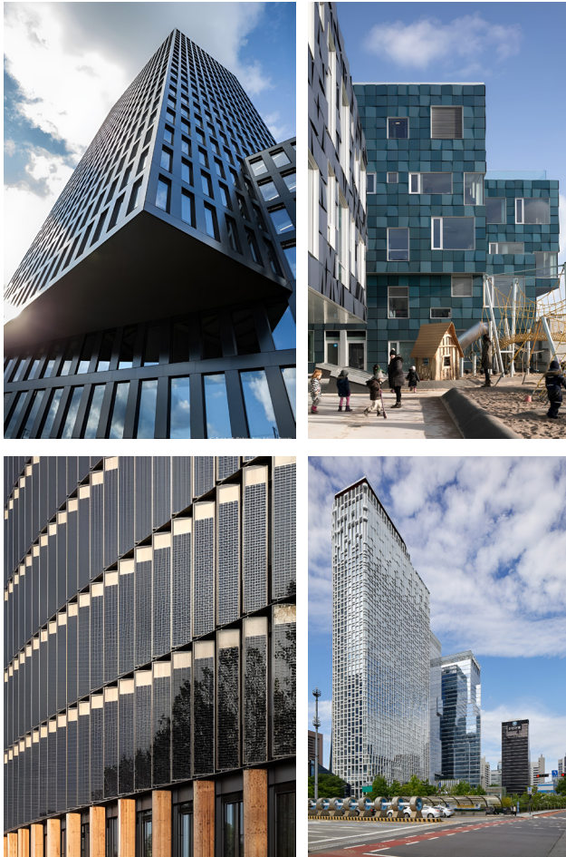
Görsel 6. Binalarla bütünleştirilen fotovoltaik panel uygulamaları (Kaya, 2022).
