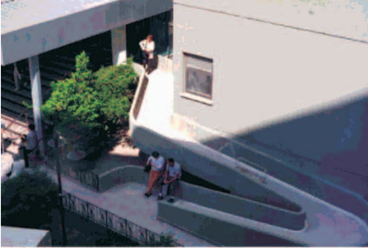
Bina giriş rampası örneği
