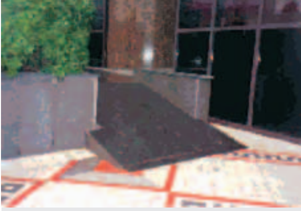
Bir hizmet binasına bu şekilde tehlikeli ve dik bir rampa yapılmış.
