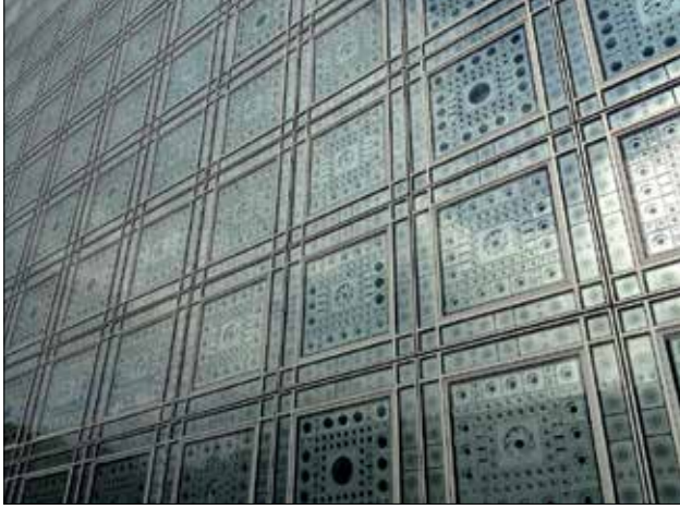
Şekil 1. Jean Nouvel'in 30,000'i aşkın mekanik biçimde etkinleştirilen aptürden oluşan Paris'teki Institut du Monde Arabe (1987) binasındaki kinetik perdeli duvar.
