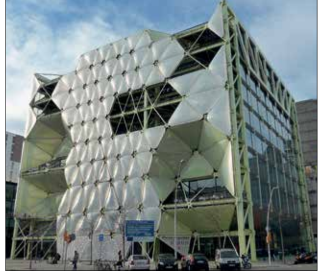
Şekil 2. Enric Ruiz-Geli'nin (Cloud9), Barselona'daki Media-TIC binası, "nefes alan", pnömatik biçimde etkinleştirilen ETFE hava yastıklarından oluşan dinamik bir cephe örneği sunmaktadır.
