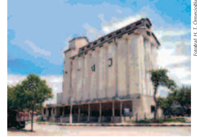
Resim 2- Polatlı silosu (1933). Yapımcı Firma Froment-Clavier
