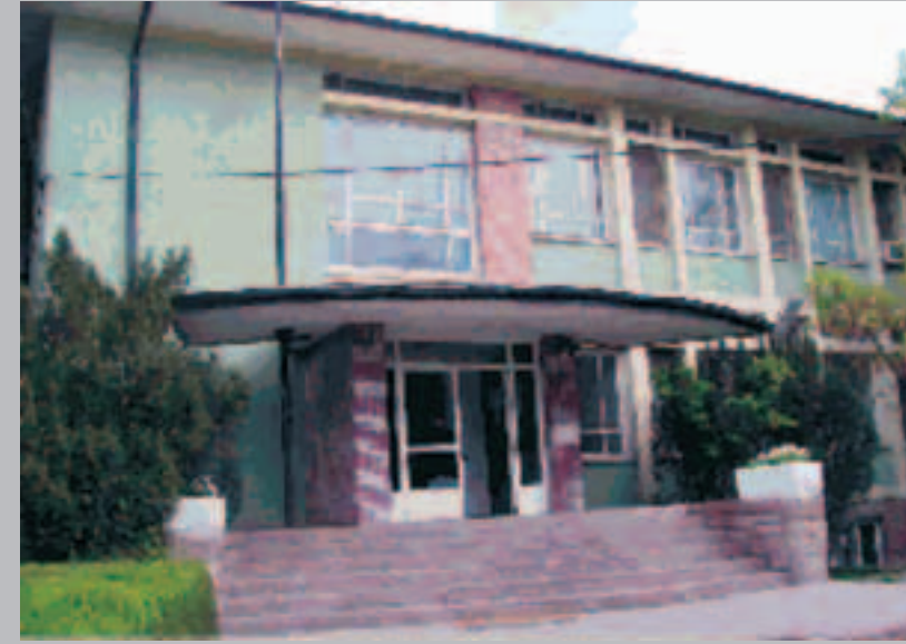
Resim 11- İdari Bina Girişi, 2006
