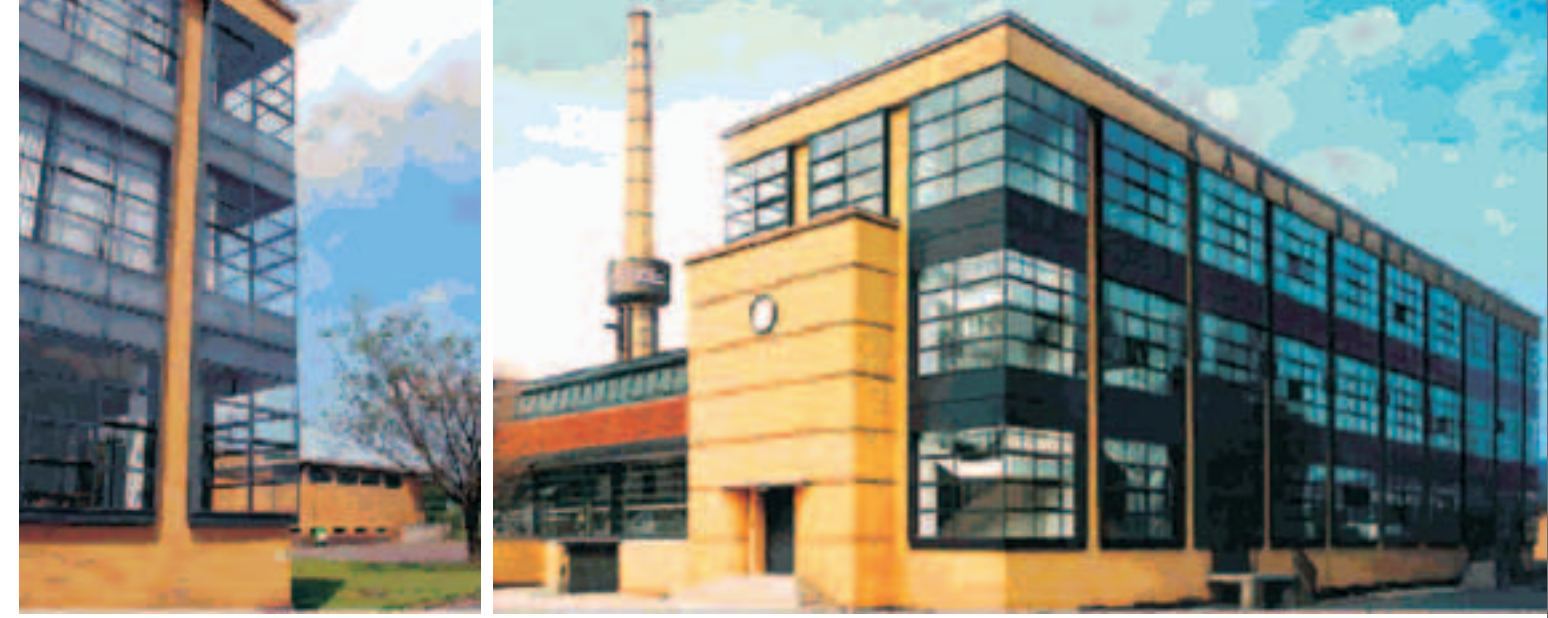
Resim 9-10 – Fagus Werk binasının kuzey-batısındaki camdan köşe ve güney-doğusundaki konsol merdivenler
