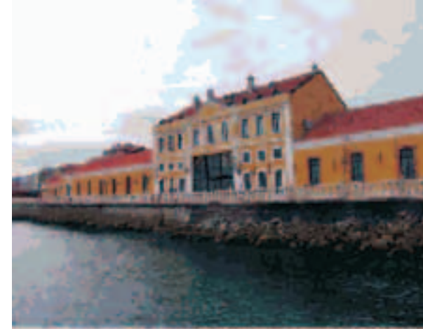
Resim 8- Otele dönüştürülmüş Mudanya İstasyonu
