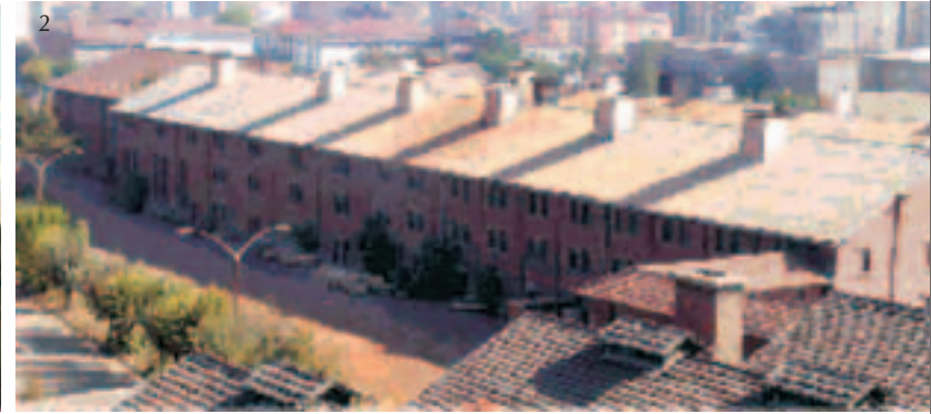
Resim 2- 2 No'lu fabrikanın genel görünümü
