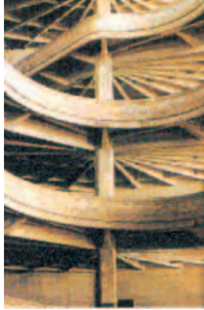
Resim 5 - Lingotto Fabrikası Çatıdaki piste çıkan rampalar
