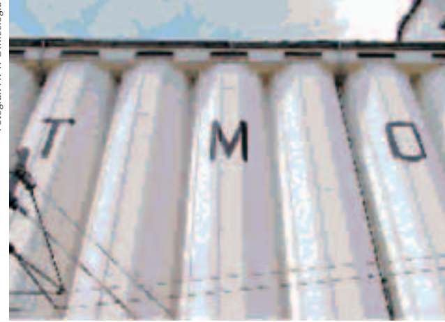
Resim 6- Polatlı Silosu prefabrik panelleri (1933) Yapımcı firma Forment-Clavier
