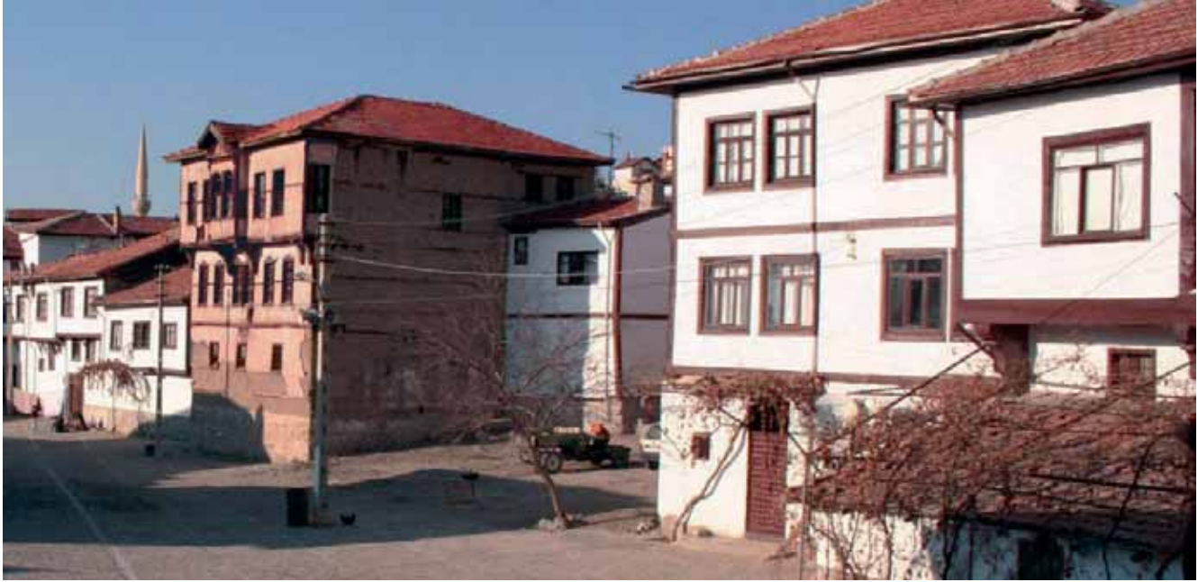
Resim 5. Güdül, Ankara'dan bir görüntü. 'Kentsel güzelleştirme ve sokak sağlıklılaştırma' adına hem geleneksel ve hem de yeni yapıların beyazlaşması ve yeni kent estetiği. Henüz müdahale görmemiş olan yapı yeni oluşan bütünlüğün içinde iyice yalnızlaşmış. (Foto: A. G. Bilgin Altınöz, 2006)
