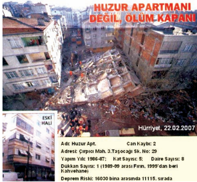
Mühendislik Tarama Çalışmaları, Bu Yapıda Öncelikli Risk Bulunmadığı Yargısına Varmıştır.
