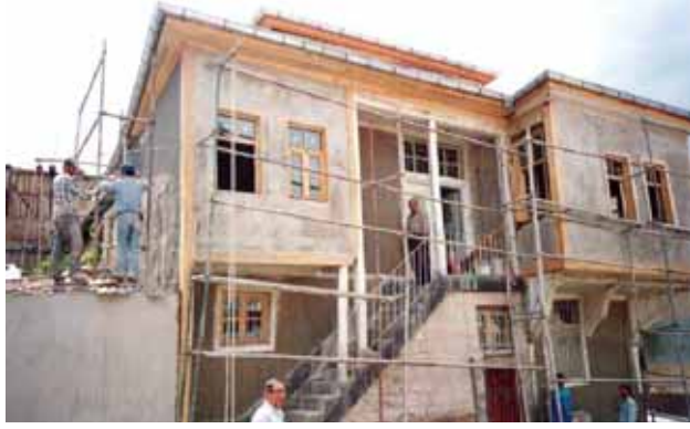
Resim 11. Cephe ve Sokak sağlıklılaştırması kapsamında sıva yenilenen bir konut.
