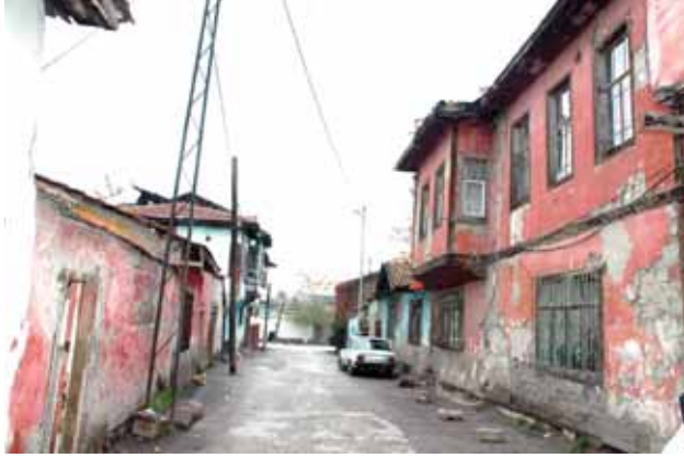
Dutlu Sokak'ın Sokak Sağlıklaştırma Projesi öncesi durumu
