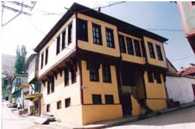
Resim 5. Cumbalı ve esas kata dışarıdan merdivenle çıkılan bir evin cephesi
