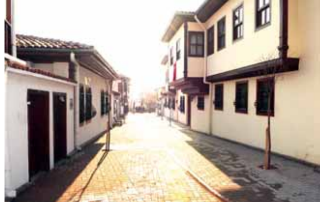
Dutlu Sokak'ın Sokak Sağlıklaştırma Projesi sonrası durumu
