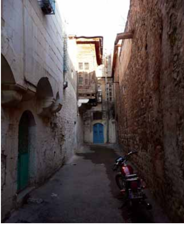
Resim 3. Kilis Kentsel Sit Alanında yer alan ve 'Kilis Sokak Sağlıklaştırma Projesi' kapsamında yer alan Salih Efendi Sokak'tan genel görünüş.
