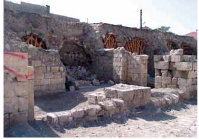
Resim 2. Belediye tarafından yürütülen projelendirme çalışmaları sırasında Hışva Han
