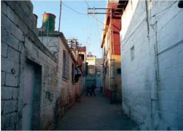
Resim 4. Kilis Kentsel Sit Alanında yer alan ve 'Kilis Sokak Sağlıklaştırma Projesi' kapsamında yer alan Salih Efendi Sokak'tan genel görünüş: Cephe bazında iyileştirilmesi talep edilen yeni yapılar.
