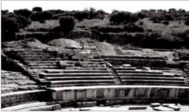
Resim 5. Meander'daki 'Theatron' un koruma müdahaleleri sonrasında görünüşü
