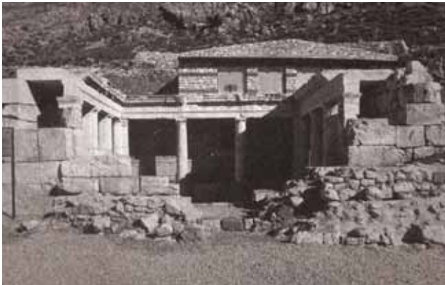
Resim 7. Geç Hellenistik Çeşme-ev'in müdahaleler sonrası durumu, Sagalassos
