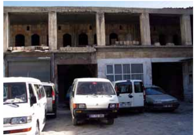
Resim 4. Mecidiye Han'da yıkılarak betonarme yapılan revağı
