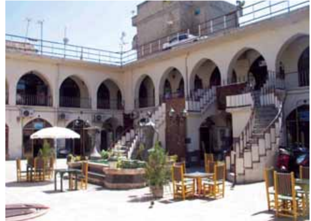
Resim 3. Yeni Han'ın yıkılarak betonarme döşeme yapılan üst örtüsünde bugün otopark kullanımı mevcut
