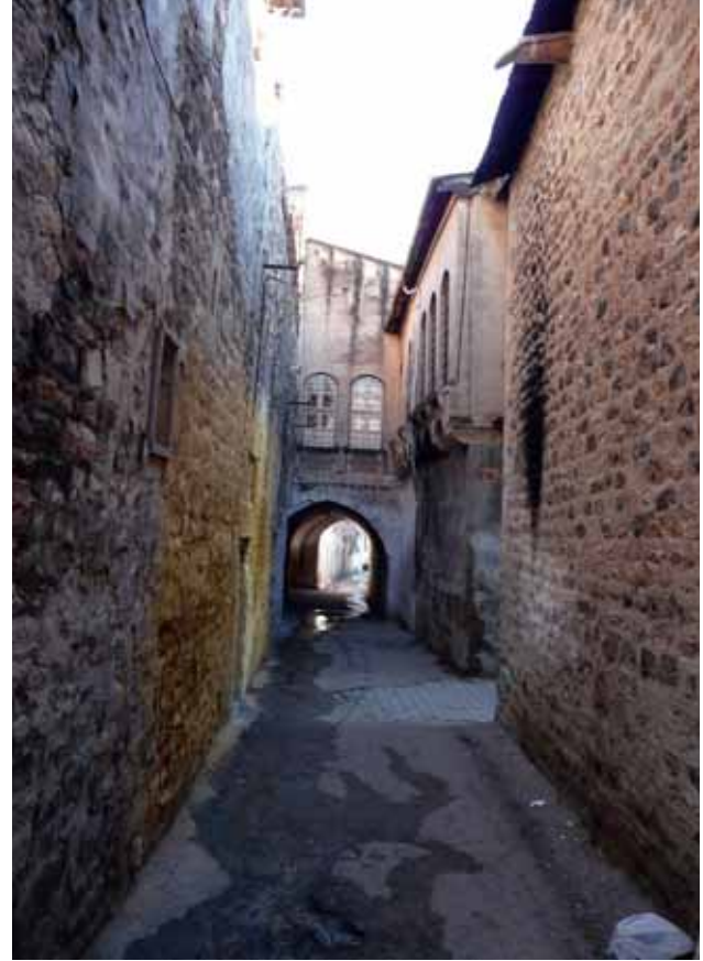
Resim 1. Kilis Kentsel Sit Alanında yer alan ve 'Kilis Sokak Sağlıklaştırma Projesi' kapsamında yer alan Salih Efendi Sokak'tan genel görünüş: İklimin ve yaşam tarzının şekillendirdiği 'içe dönük' mimaride sokağı taş duvar dokusu tanımlamaktadır
