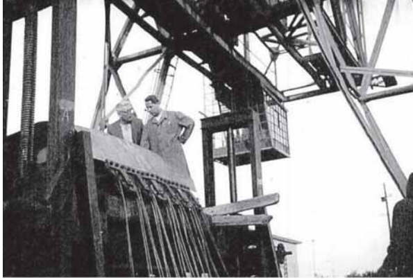
Şekil 7. Gövde saclarının beton kalıplar üzerine krika yardımı ile çekilmesi
