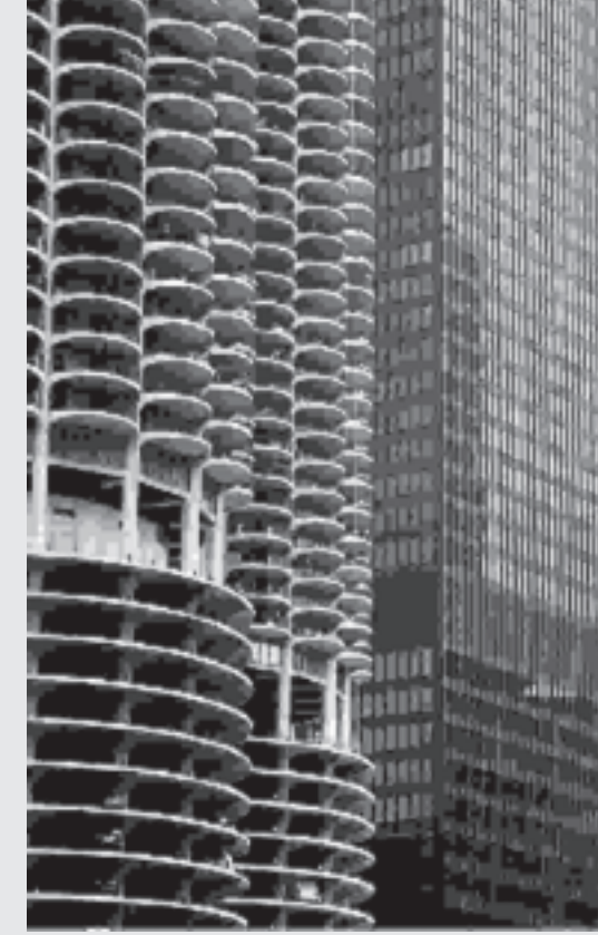
Resim-26 Bauhaus okulunda eğitilmiş Almanya kökenli Bertrand Goldberg, doğada düz çizgi yok gerekçesi ile kavisli dış kontur ve pencere, çıplak beton cepheli binalar tasarlamıştır. Zenginler konutu olan Marina City ve River City ile aynı tarzda, South Halsted caddesi üzerinde düşük gelir gurubu için tasarımları vardır.
