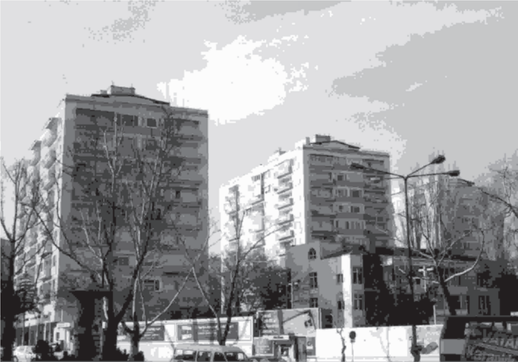
İlbank Evleri, İran Caddesi cephesi
