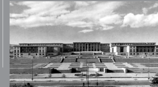
Clemens Holzmeister TBMM
