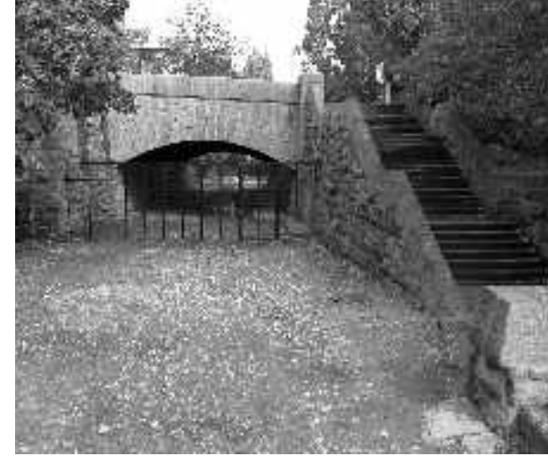
Güvenlik Caddesi'ndeki Köprü Altı Demir Engelle Kapatıldı
