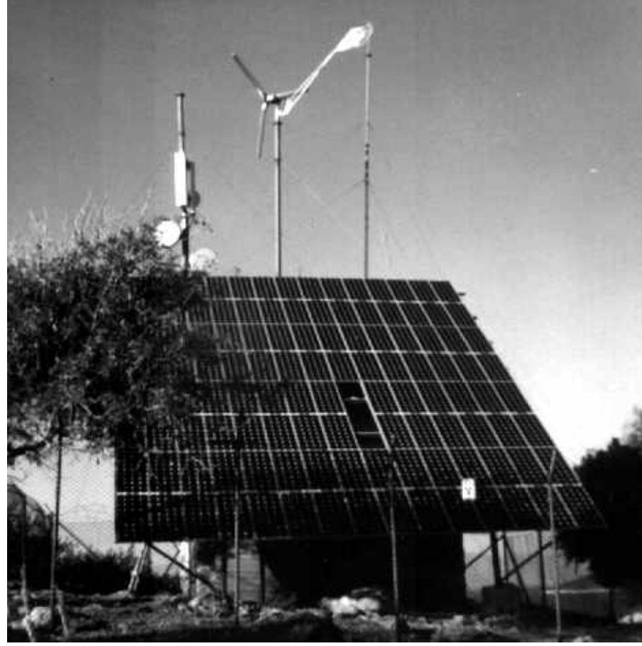
Bodrum-ikizadalar, rüzgar ve güneş enerjisi ile çalışan Telekomünikasyon sistemi
