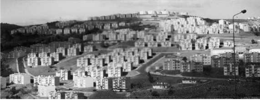
7 Gündoğdu Kalıcı Konutları Mevcut yerleşmelerden kilometrelerce uzakta ama sağlam zeminde(!) yapılan konutlar imar sistemimizin kusurlarını da ortaya koymakta.
